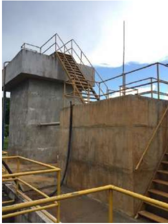
Figura 108 - Sistema de Tratamento de Lodo Fonte: Amplar Engenharia
