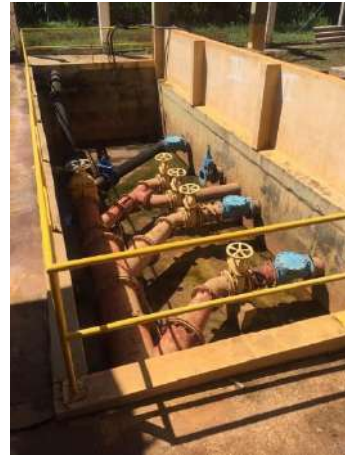
Figura 160 - Conjunto moto-bomba da EEEB ETE Laranja Azeda Fonte: Amplar Engenharia
