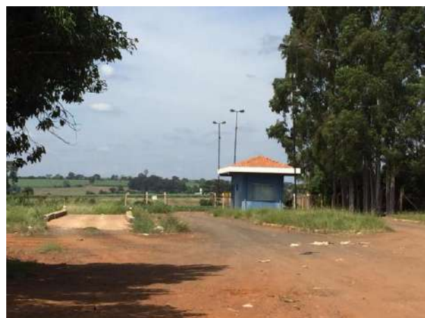
Figura 246 - Guarita e balança do Aterro Sanitário Fonte: Amplar Engenharia
