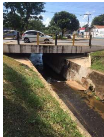
Figura 285 - Ribeirão do Ouro – Ponte da Av. Amador Bueno Fonte: Amplar Engenharia
