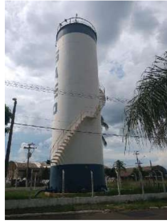
Figura 131 - Reservatório Vila São Pedro Fonte: Amplar Engenharia
