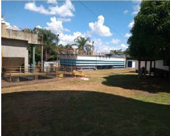
Figura 81 - Foto Geral ETA III Fonte: Amplar Engenharia
