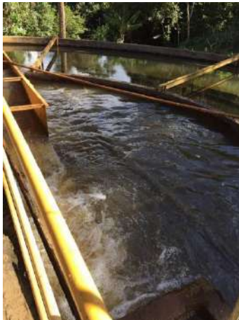
Figura 50 - Floculador ETA I Fonte: Amplar Engenharia
