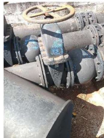
Figura 31 - Captação do Ribeirão do Roque Fonte: Amplar Engenharia
