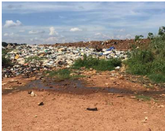
Figura 253 - Vala em operação Fonte: Amplar Engenharia
