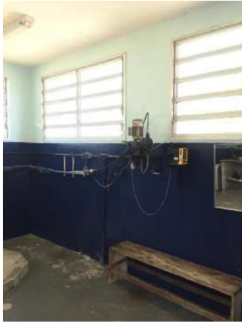
Figura 87 - Dosadora manual de produtos químicos Fonte: Amplar Engenharia
