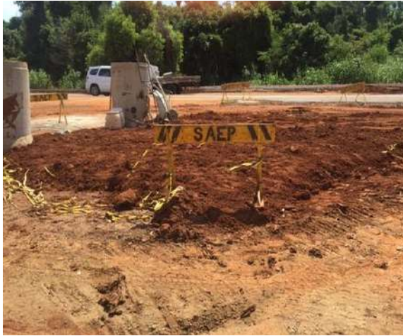
Figura 287 - Obras de ampliação e troca de tubulação Fonte: Amplar Engenharia
