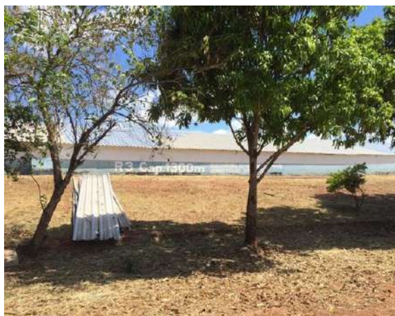
Figura 116 - R3 ETAs II e III Fonte: Amplar Engenharia
