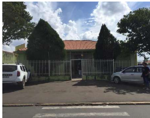
Figura 270 - USF Dr. João Antônio Del Nero, Bairro Vila São Pedro Fonte: Amplar Engenharia
