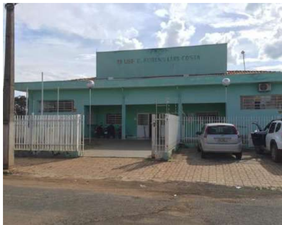
Figura 269 - USF Dr. Rubens Luis Costa, Bairro Parque Clayton Malaman Fonte: Amplar Engenharia
