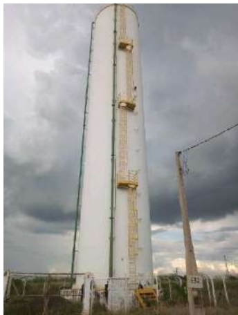
Figura 136 - Reservatório Terras de Santa Maria Fonte: Amplar Engenharia
