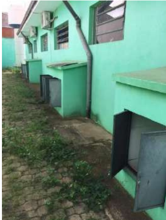
Figura 271 - Cabines para disposição dos resíduos a serem coletados Fonte: Amplar Engenharia
