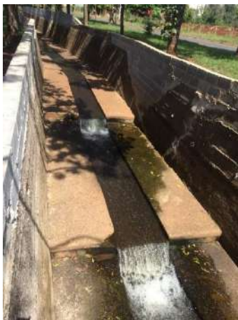
Figura 284 - Ribeirão do Ouro – Ponte da Av. Painguás Fonte: Amplar Engenharia
