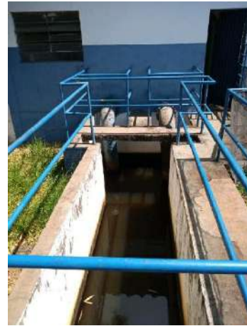
Figura 44 - Entrada da captação Fonte: Amplar Engenharia
