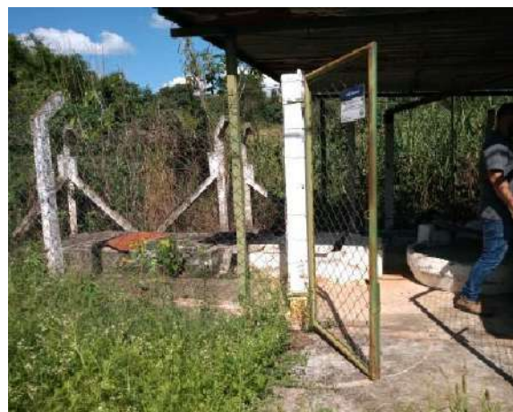
Figura 178 - EEEB Mamonal parte baixa Fonte: Amplar Engenharia
