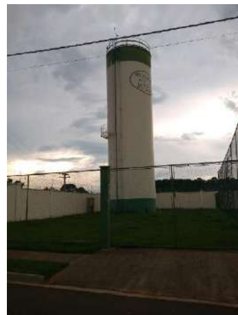
Figura 135 - Reservatório Jd. Alto do Jatobá Fonte: Amplar Engenharia
