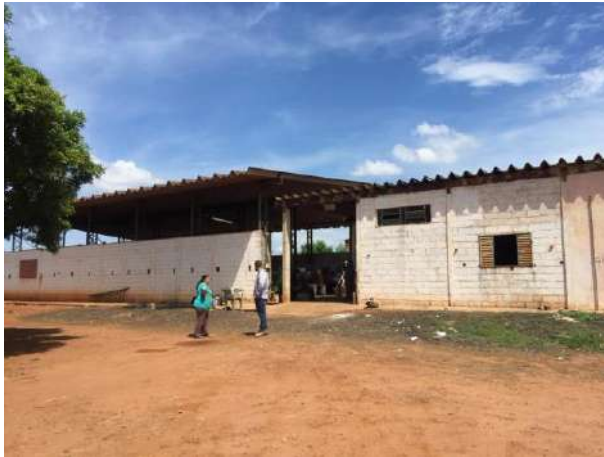
Figura 257 - Entrada do Galpão da COOPEREP Fonte: Amplar Engenharia
