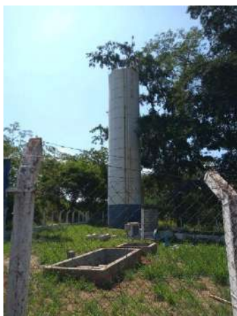
Figura 146 - Reservatório elevado Ch. de Emas Fonte: Amplar Engenharia
