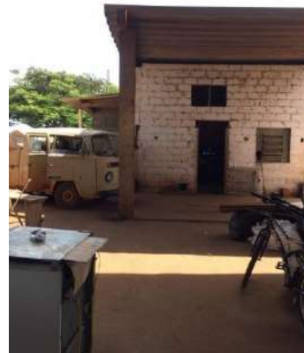
Figura 260 - Casa de descanso dos cooperados Fonte: Amplar Engenharia
