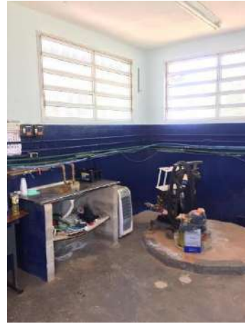
Figura 88 - Dosadora manual de produtos químicos Fonte: Amplar Engenharia
