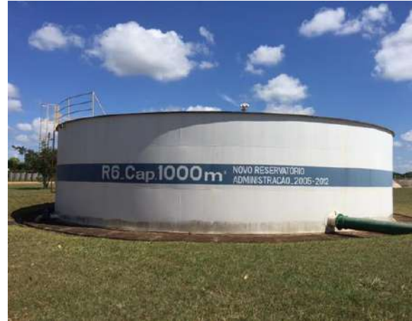
Figura 119 - R6 das ETAs II e III Fonte: Amplar Engenharia
