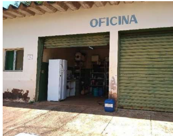
Figura 205 - Oficina da ETE Laranja Azeda Fonte: Amplar Engenharia
