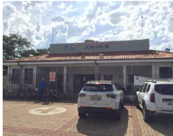
Figura 268 - USF João Baldi, Bairro Vila Santa Fé Fonte: Amplar Engenharia
