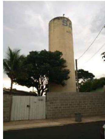
Figura 125 - Reservatório Vila Guilhermina Fonte: Amplar Engenharia
