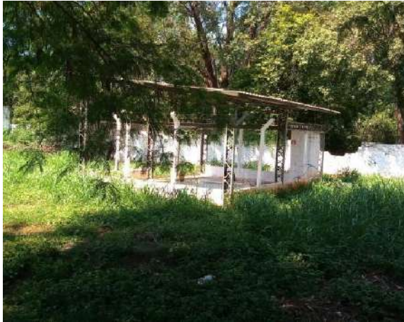
Figura 182 - EEEB Limoeiro Fonte: Amplar Engenharia
