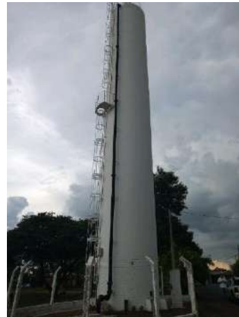
Figura 133 - Reservatório Jd. Ferrari II Fonte: Amplar Engenharia
