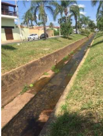
Figura 286 - Ribeirão do Ouro – Ponte da Av. Amador Bueno Fonte: Amplar Engenharia
