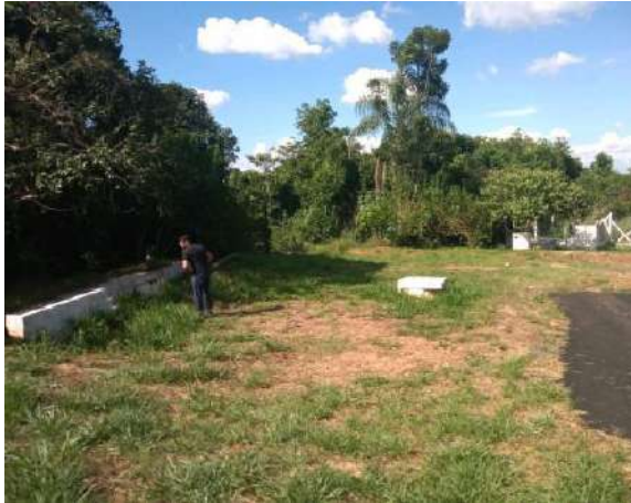
Figura 163 - EEEB Verona Fonte: Amplar Engenharia
