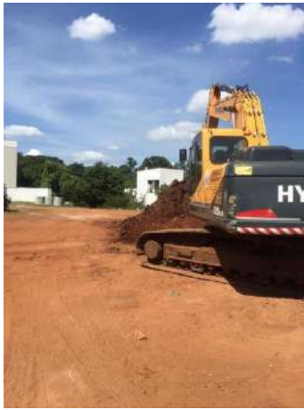
Figura 289 - Obras de ampliação e troca de tubulação Fonte: Amplar Engenharia
