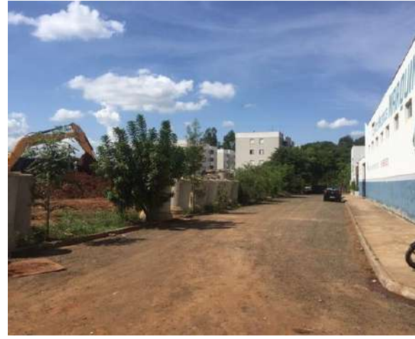
Figura 288 - Obras de ampliação e troca de tubulação Fonte: Amplar Engenharia
