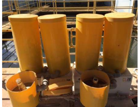
Figura 55 - Adição de produtos químicos Fonte: Amplar Engenharia
