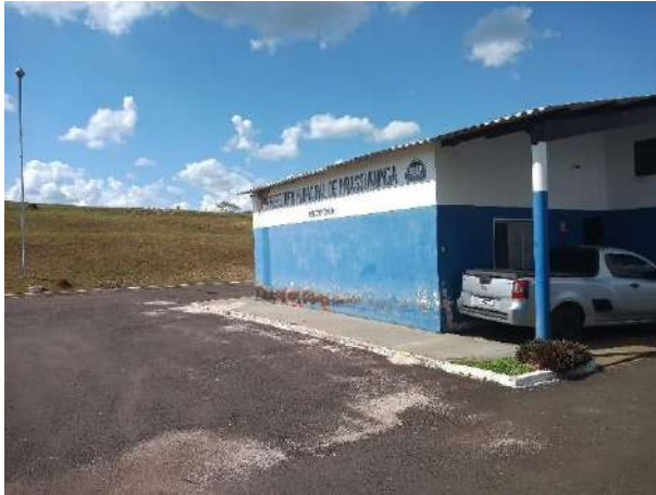
Figura 40 - Escritório da captação Fonte: Amplar Engenharia
