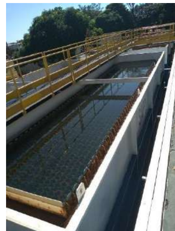
Figura 74 - Ampliação ETA II Fonte: Amplar Engenharia
