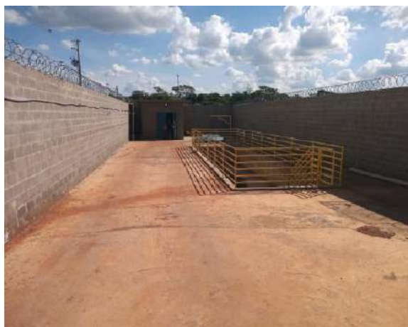
Figura 171 - EEEB Amente Fonte: Amplar Engenharia
