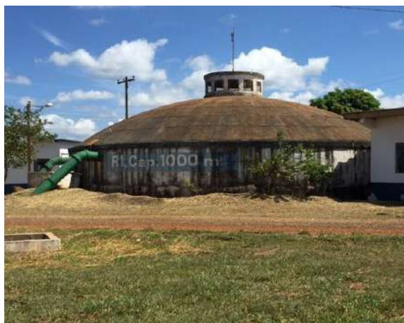
Figura 114 - R1 das ETAs II e III Fonte: Amplar Engenharia
