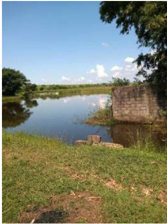
Figura 43 - Córrego da Barra Fonte: Amplar Engenharia
