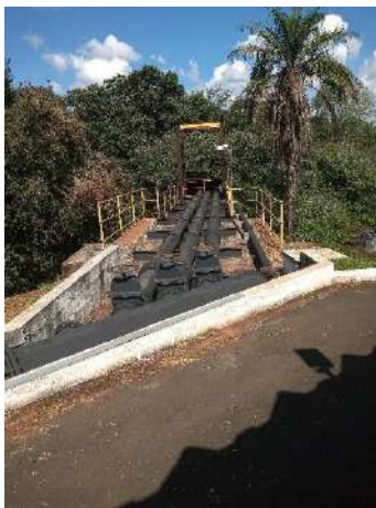
Figura 30 - Captação do Ribeirão do Roque Fonte: Amplar Engenharia
