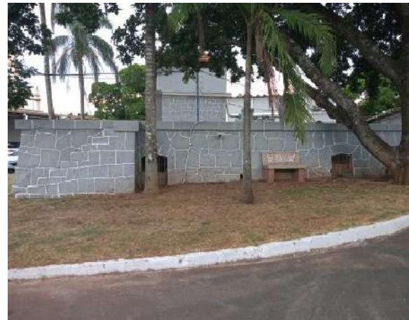
Figura 123 – Reservatório 1 Pátio da SAEP Fonte: Amplar Engenharia
