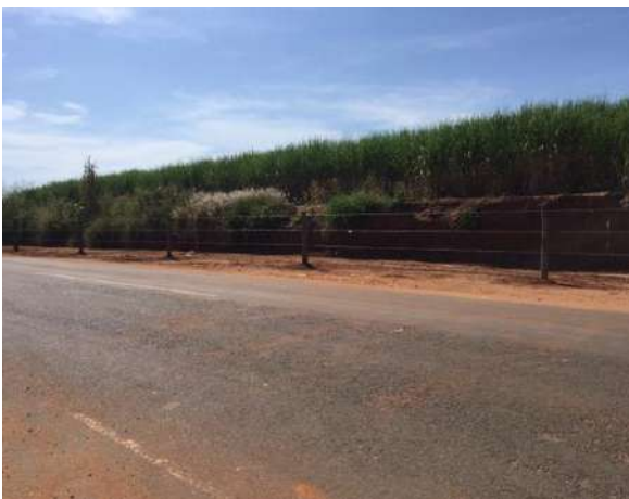
Figura 239 – Antigo descarte irregular de resíduo Fonte: Amplar Engenharia
