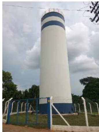
Figura 137 - Reservatório Jd. São João Fonte: Amplar Engenharia
