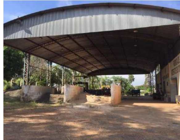
Figura 242 - Fábrica de Artefatos de Cimento Fonte: Amplar Engenharia
