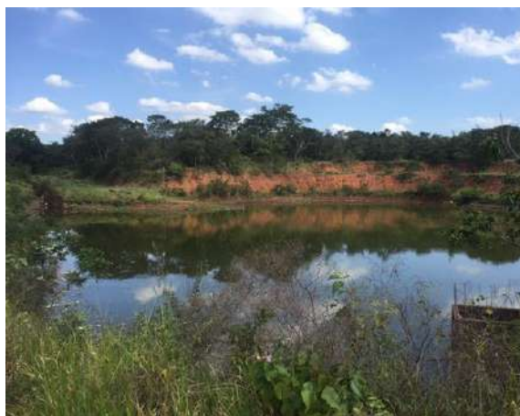
Figura 292 - Bacias de retenção e detenção do Horto Ambiental Fonte: Amplar Engenharia
