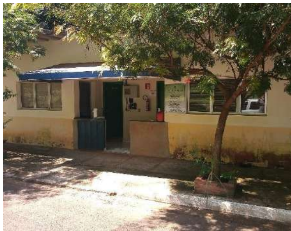
Figura 206 - Prédio administrativo e laboratório da ETE Laranja Azeda Fonte: Amplar Engenharia
