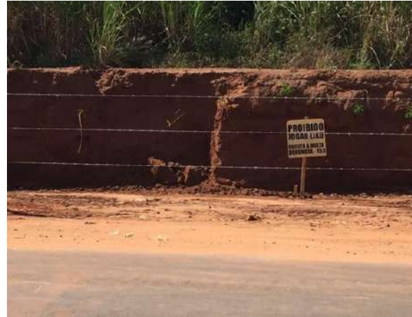
Figura 238 - Antigo descarte irregular de resíduo Fonte: Amplar Engenharia
