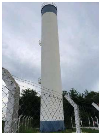
Figura 145 - Reservatório Jd. Santa Clara (Sta. Fé) Fonte: Amplar Engenharia
