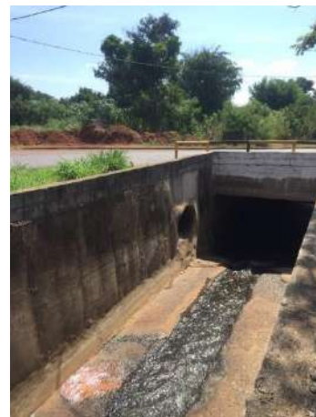
Figura 283 - Ribeirão do Ouro – Ponte da Av. Painguás Fonte: Amplar Engenharia
