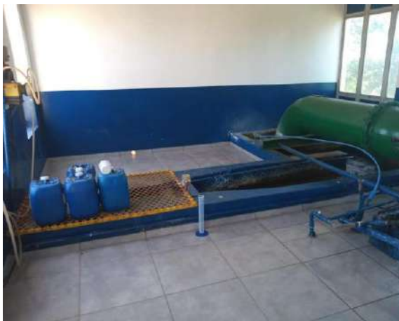
Figura 65 - Entrada de água na Calha Parshall – ETA II Fonte: Amplar Engenharia
