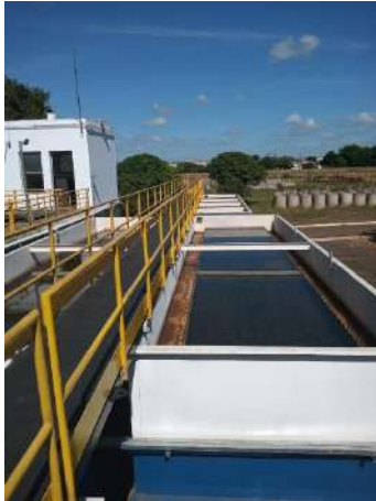
Figura 75 - Ampliação ETA II Fonte: Amplar Engenharia
