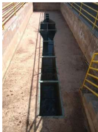
Figura 172 - EEEB Amente Fonte: Amplar Engenharia
