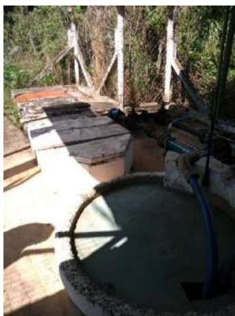
Figura 179 - EEEB Mamonal parte baixa Fonte: Amplar Engenharia
