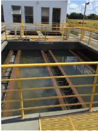
Figura 69 - Decantador 2 ETA II Fonte: Amplar Engenharia
