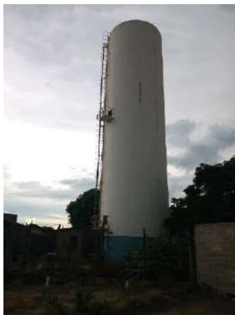
Figura 126 - Reservatório Vila Esperança Fonte: Amplar Engenharia
