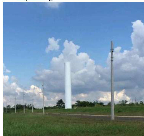
Figura 127 - Reservatório Jd. Laranjeiras Fonte: Amplar Engenharia
