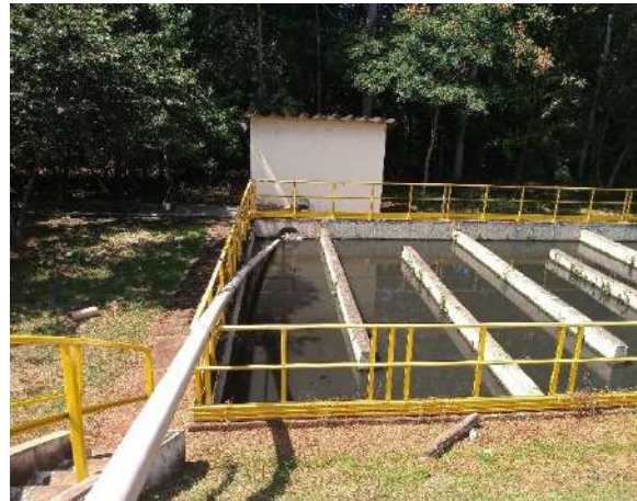
Figura 203 - Lodo formado na desinfecção ETE Laranja Azeda Fonte: Amplar Engenharia
