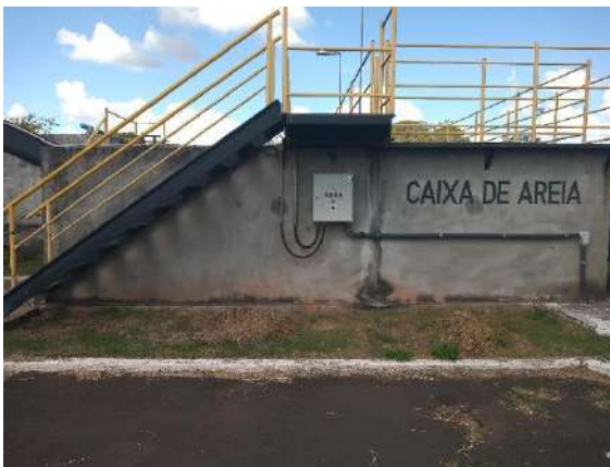
Figura 36 - Caixa de areia Fonte: Amplar Engenharia
