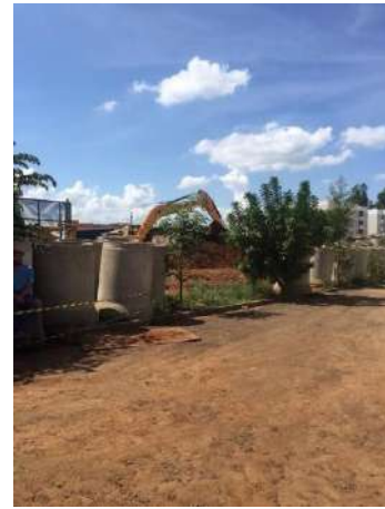
Figura 290 - Obras de ampliação e troca de tubulação Fonte: Amplar Engenharia
