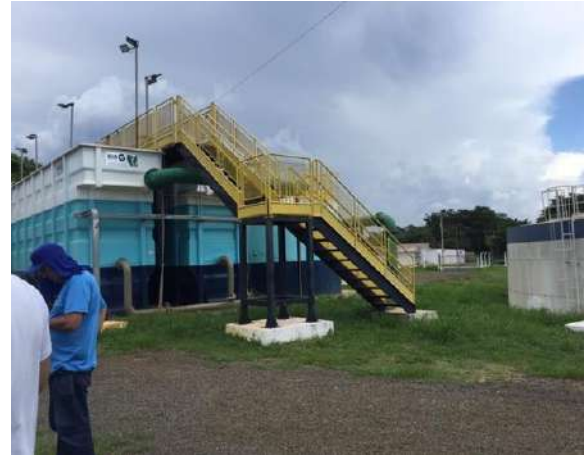
Figura 95 - Foto Geral da ETA Santa Fé (em operação) Fonte: Amplar Engenharia
