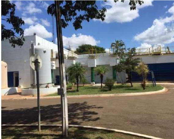
Figura 63 - Foto geral da ETA II Fonte: Amplar Engenharia
