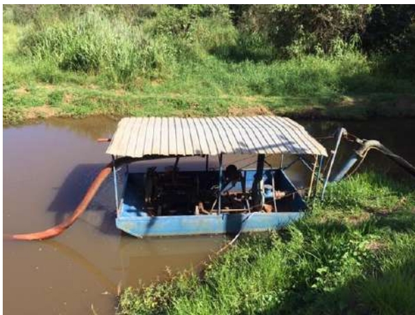
Figura 23 - Captação Ribeirão Descaroçador Fonte: Amplar Engenharia
