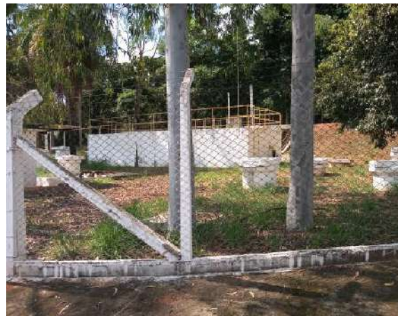
Figura 176 - EEEB Mamonal parte alta Fonte: Amplar Engenharia
