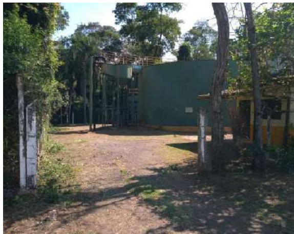
Figura 210 - Entrada ETE Santa Fé Fonte: Amplar Engenharia
