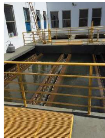
Figura 68 - Decantador 1 ETA II Fonte: Amplar Engenharia
