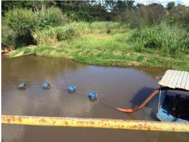
Figura 21 - Captação Ribeirão Descaroçador Fonte: Amplar Engenharia
