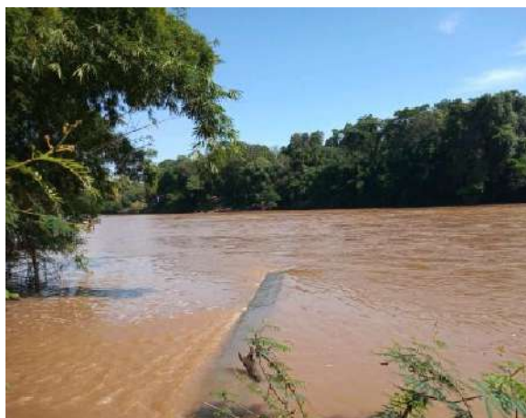
Figura 216 - Ponto de lançamento do esgoto tratado ETE Santa Fé Fonte: Amplar Engenharia
